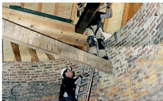
Den Mühlenexperten wird echte Maßarbeit abverlangt, die neue Kappe muss exakt auf der Außenmauer abgelegt werden.
